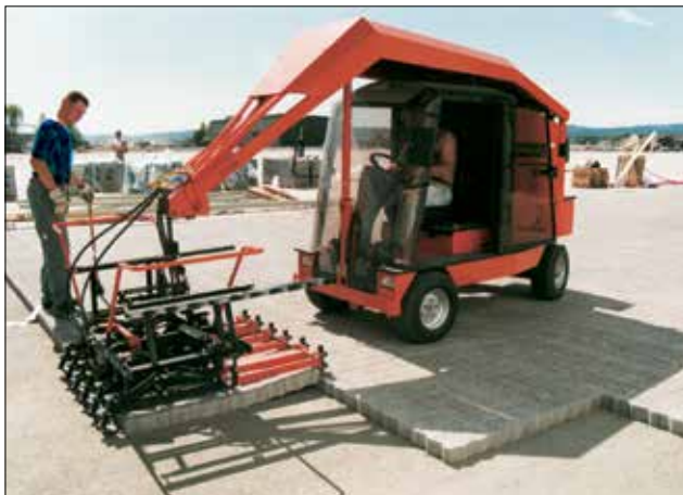
Maskinnedlægning af betonsten – hurtigt og effektivt.
